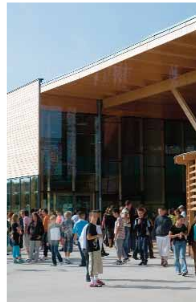
Face à la croissance démographique : construction du collège de Montech
